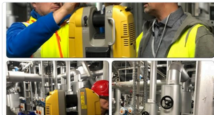
Aufmaß vor Ort – Scan einer Technikzentrale
